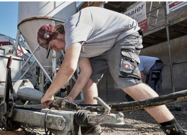
Anschluss eines Mörtelschlauches an eigener Fließestrichpumpe
