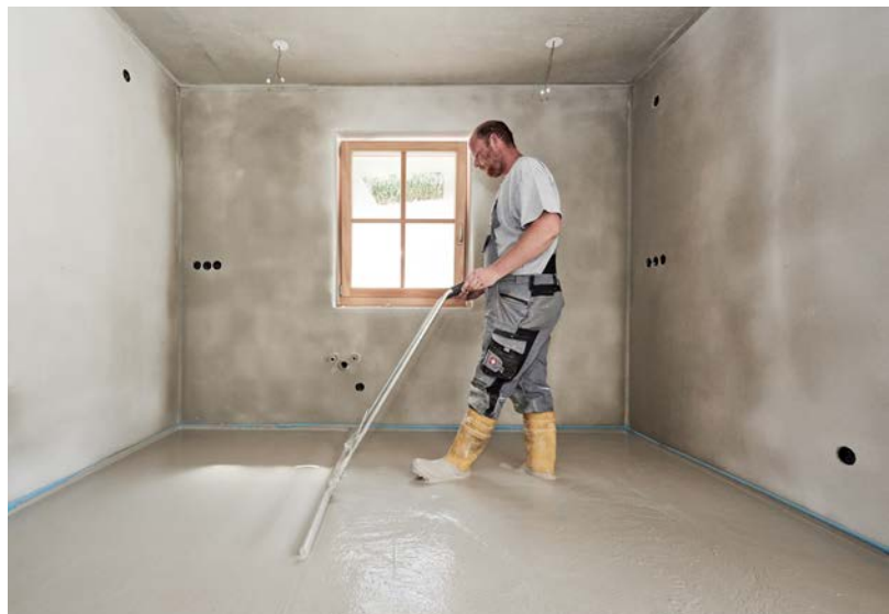
Verdichten des Materials
