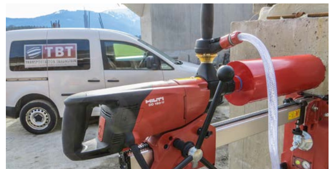
Bohrkernentnahme bis 40 cm Tiefe, verschiedene Durchmesser
